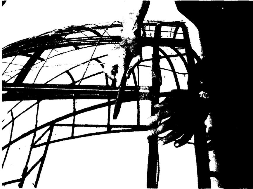
Figura 64. Limpieza y lijado de la superficie.
