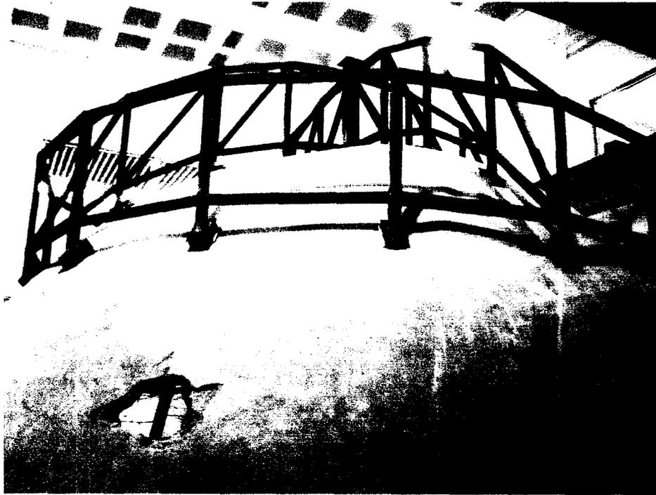
**Figura 76.** Perforación realizada para exponer la estructura metálica.
