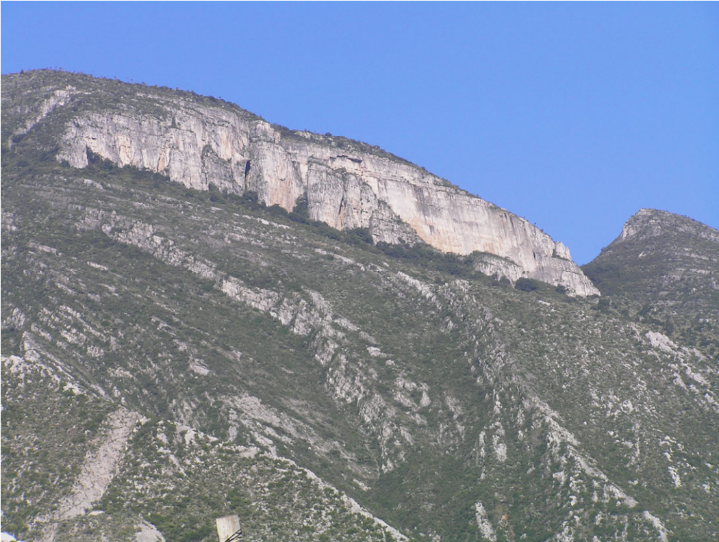
Foto 1. Área de derrumbe
